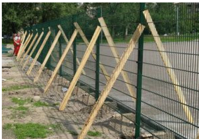
Рис.3. Сборка ограждения перед бетонированием.
